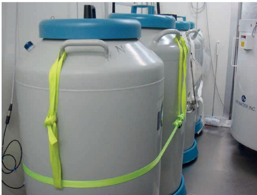
Los tanques de almacenamiento se mantuvieron intactos durante el terremoto de 2011 en Japón porque estaban conectados por correas duras (verdes) y ruedas (azules) que absorbieron las sacudidas. Cortesía del BSCU Miyagi .
